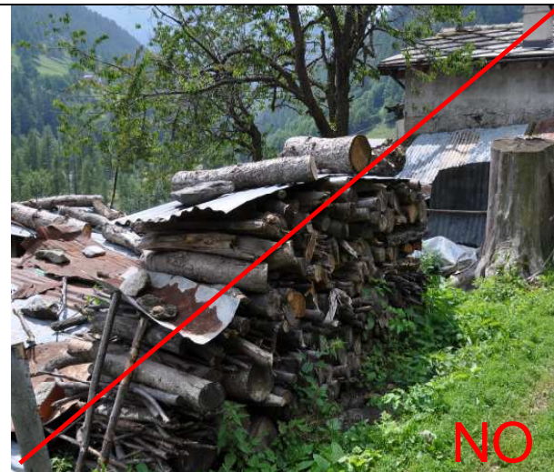
Fig.3- Coperture arrugginite e mal posizionate
